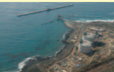
Vista panorámica de la terminal GNL
