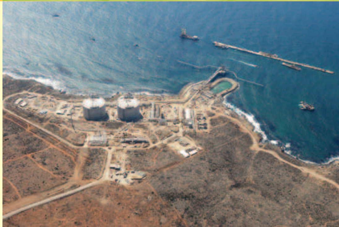
La construcción de Energía Costa Azul se encuentra en su última fase
